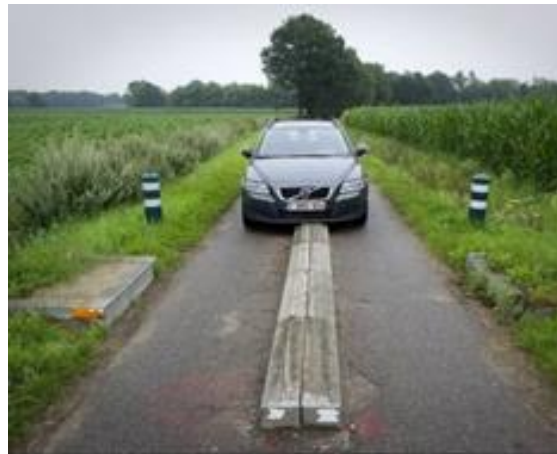
Figure 5 : Écluse à tracteur dissuasive pour les voitures (Source : https://securotheque.wallonie.be/ , consulté en décembre 2023).
