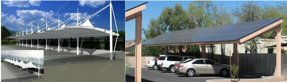
Figure 6 : Ombrières en zones de parking (Sources : gauche, BDIR ; droite : Colibri Solar)
